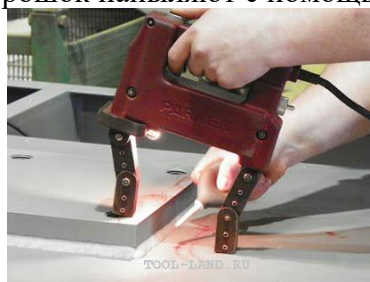
Рисунок 61 - Проверка качества сварных швов магнитопорошковой дефектоскопией (сухим способом)
