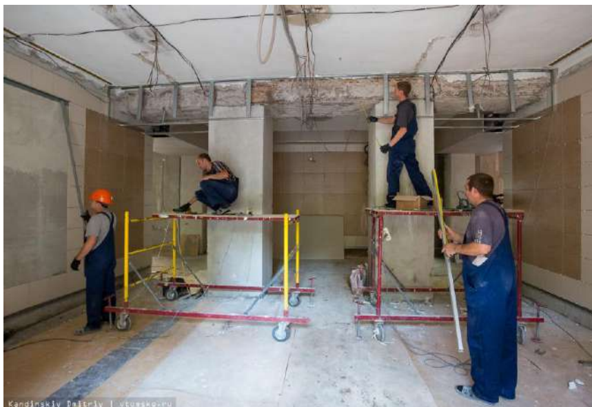
Фото 1 – Подготовка помещения на реконструируемом предприятии под монтаж оборудования
