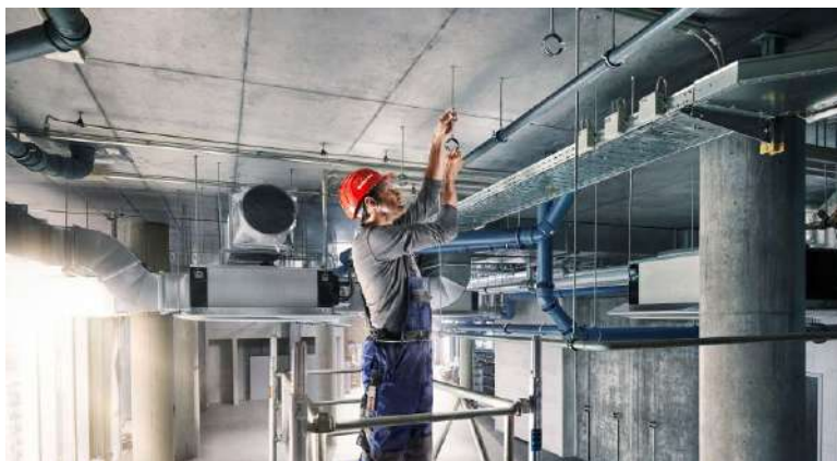
Фото 5 – Монтаж вентиляционной системы
